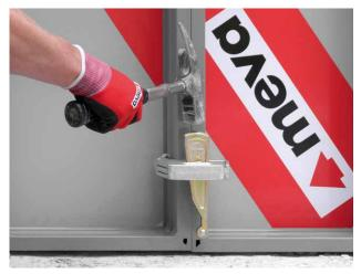
AluFix benötigt 50% weniger Verbindungs- und 25% weniger Ankerteile als Kunststoffschalungen. Daraus resultieren geringere Materialvorhaltung und effizientes Arbeiten.
